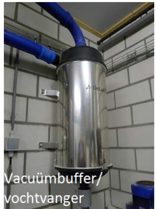
Figuur 2: Vacuümbuffer/vochtvanger (machiniekamer)
