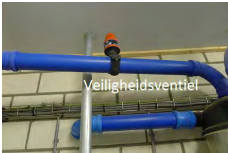
Figuur 3: Veiligheidsventiel (machinekamer)
