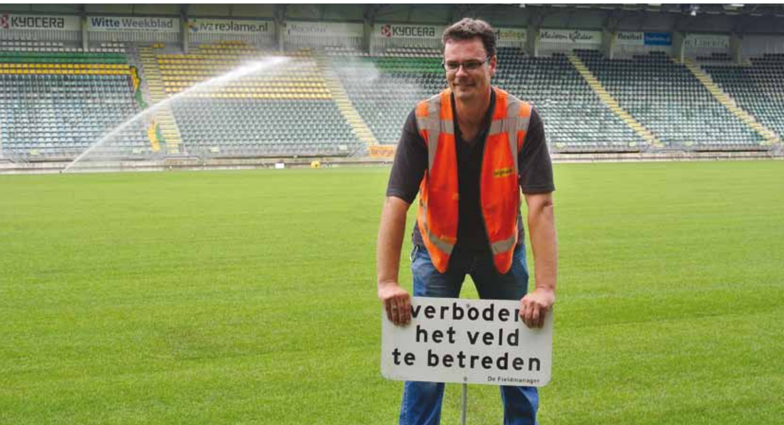
Het voorlopige resultaat: natuurgras. De graszoden zijn geïnstalleerd door het team van Uniek Graszoden uit Heerle en grondverzetbedrijf G. van den Bos uit Doorn. Op de foto Thijs van Lierop van hoofdaannemer Heijmans.
