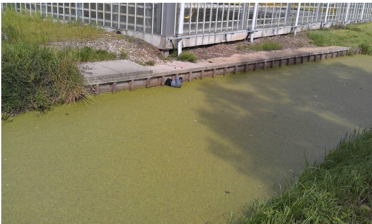
Figuur 3 Gemonteerde opzetstuk in de sloot. Let ook op de grote hoeveelheid kroos.
