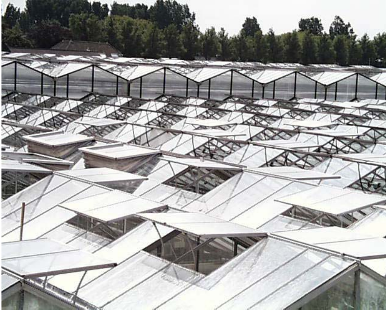
Figuur 1: Een huidige kas. Bij een semi-gesloten kas worden de luchtramen minder (ver) geopend
