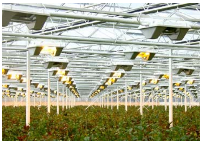
Figuur 4 Belichting is vanwege de grote warmte productie moeilijk met koeling te combineren
