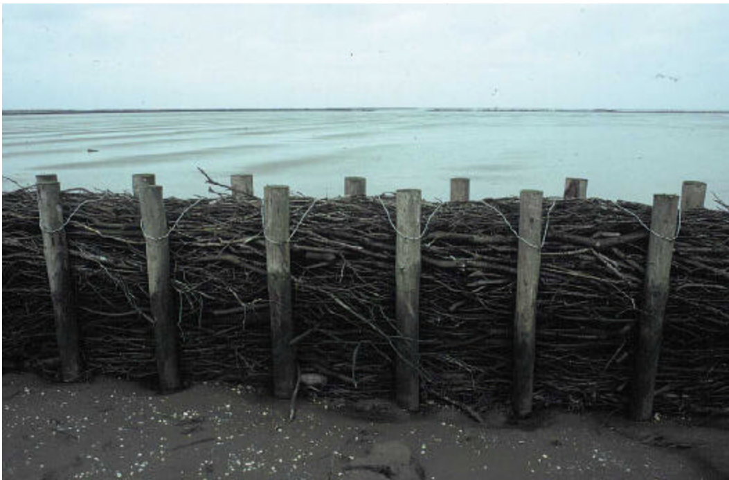
Figuur 1. Inlandse eik werd van oudsher gebruikt voor de vulling van rijshoutdammen.
