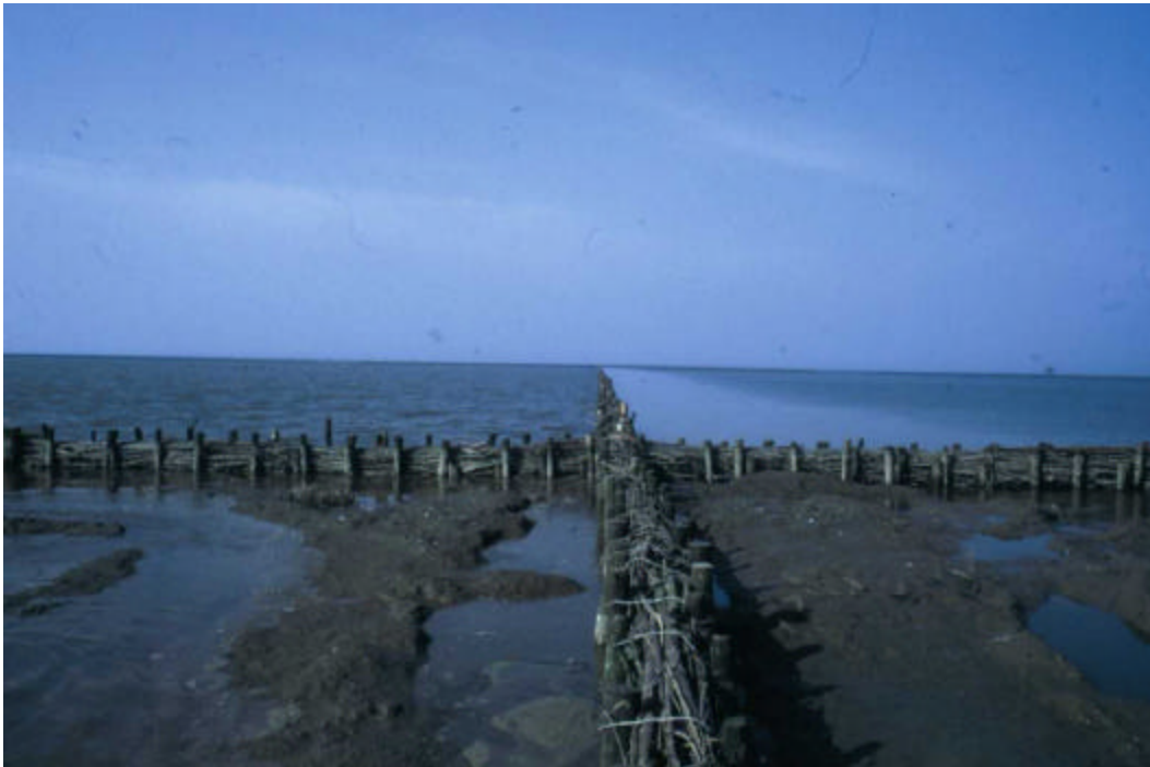
Figuur 3. Langs- en dwarsdammen aan de Groningse kust; duidelijk is de dempende werking van de dammen op de golfslag te zien. Eenzelfde demping treedt ook op in de stroming bij getijdenwisselingen.
