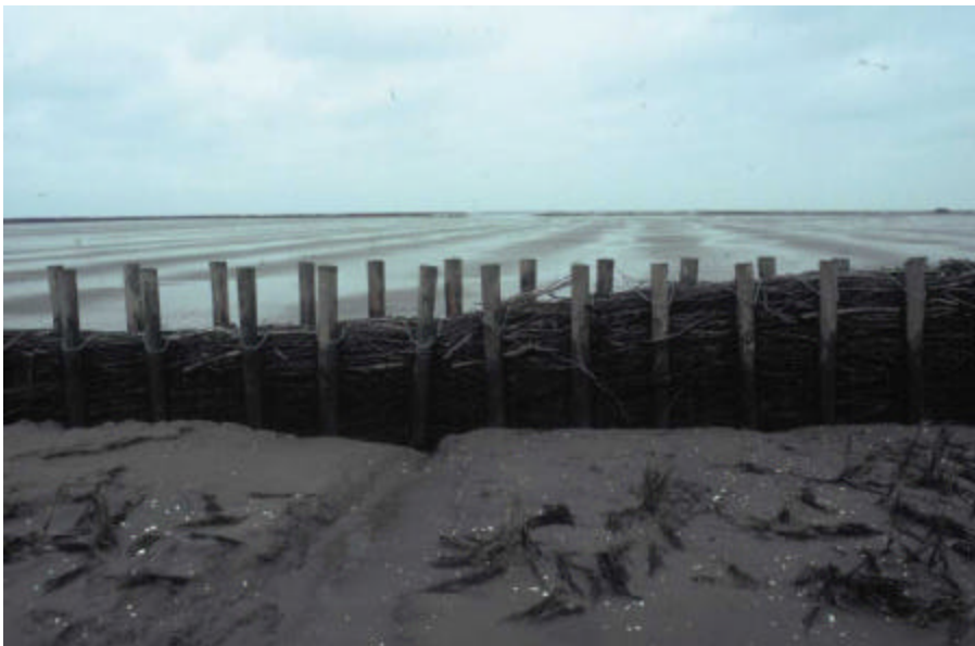
Figuur 7. Een geleidelijke overgang van vulling met Inlandse eik (rechts) en Tamme kastanje (links).
