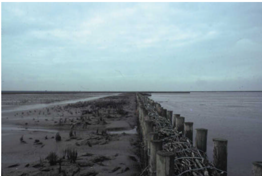
Figuur 9. De aanwas van grond aan de landzijde (links) is duidelijk waar te nemen. Dit damstuk is gevuld met Amerikaanse eik.
