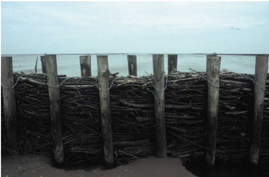
Figuur 10. Amerikaanse vogelkers als vulling voor dit damstuk met rechts een spoelgat.
