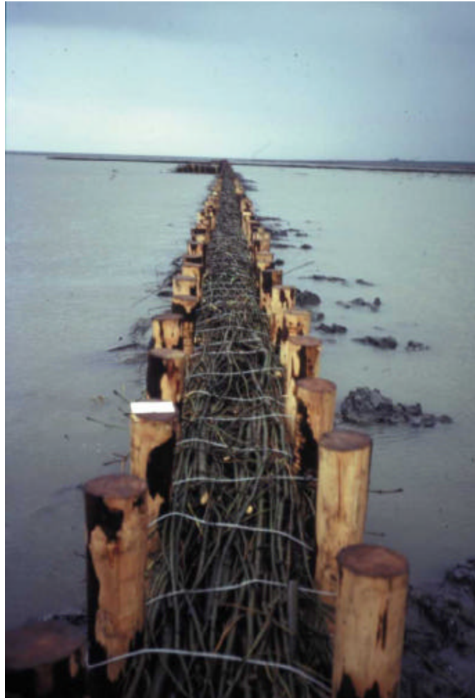
Figuur 14. Bovenaanzicht van een rijshoutdam gevuld met Amerikaanse eik.
