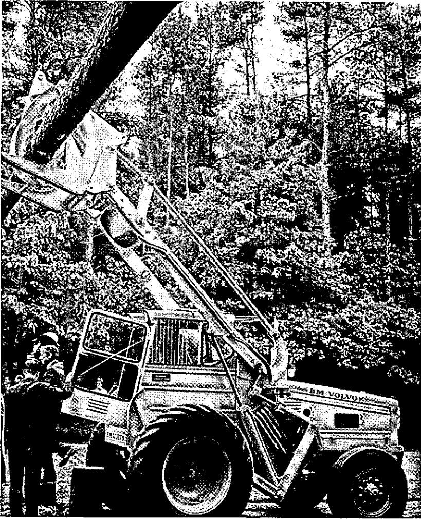
Burgemeester des Tombe heeft de opening verricht: het heffen van een zware stam door een motorkraan met houtgrijper.
