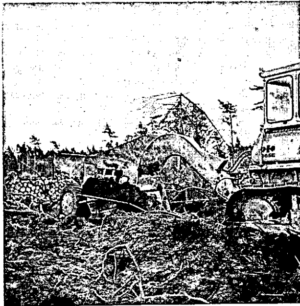
3 De Martlini-greppelploeg KLM 240 achter bulldozer van ca. 155 DIN PK.
