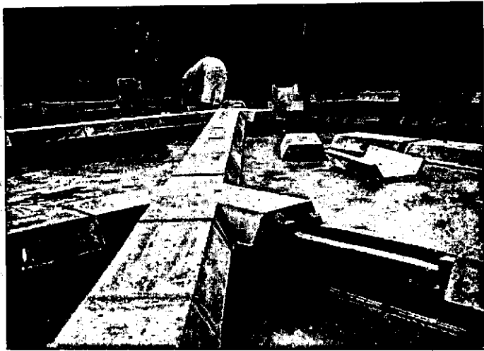
Afb. 6. Het aanbrengen van de gootdekplaten.
