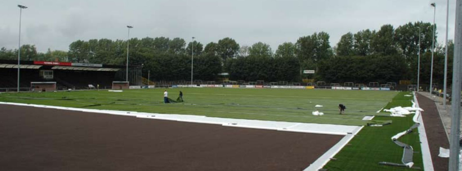
Aanleg van een kunstgrasveld bij voetbalclub DHC
