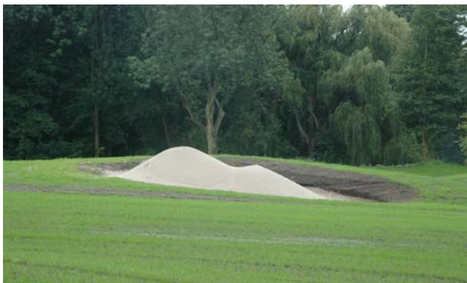
Bunkerzand uit aanleg kunstgrasveld. Met de grond die is vrijgekomen door de aanleg van de kunstgrasvelden heeft de gemeente nieuwe mounts en bunkers kunnen aanleggen in haar golfbaan.
