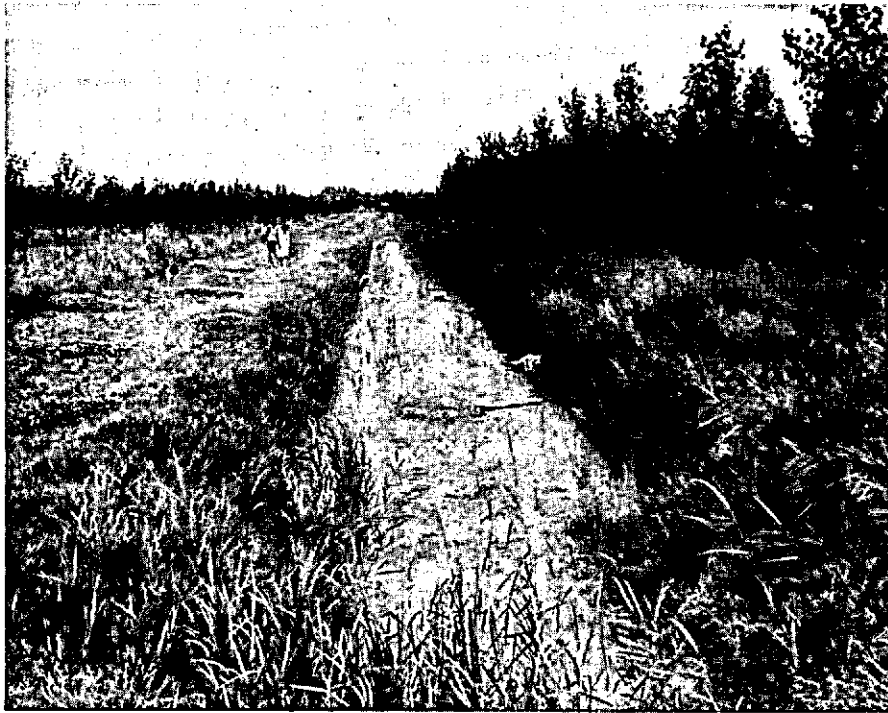
■ Hoofdwatgang met daarlangs een 10 meter brede onbeplante strook grond voor het storten van bagger.
