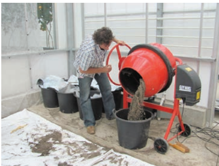
Foto nr. 2. De gezeefde kasgrond wordt in een betonmolen gemengd met rivierzand, op basis van een volumeverhouding van één op één.
