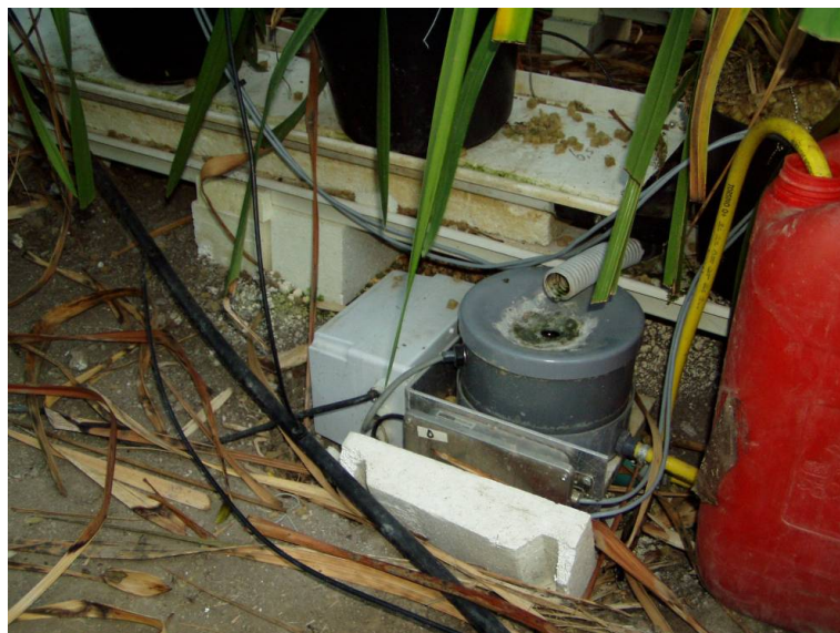
Drainopvangsysteem met drainteller en voorraadvat voor de bemonstering van drainwater.
