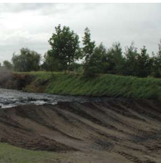
De baan leegbaggeren. De Goese Golfbaan slaat de drek
