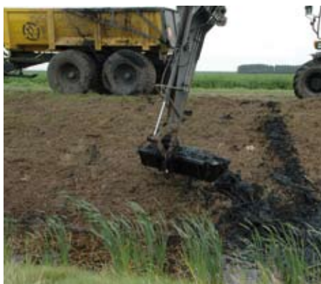
Kraanmachine baggert de poldersloot uit.
