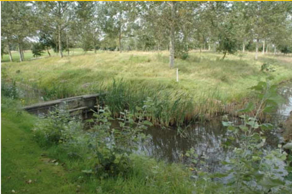
Links: De golfbaan met sluis. Rechts: De poldersloot. Rutjes: "Met de sluis regelen we het waterniveau op de baan."
