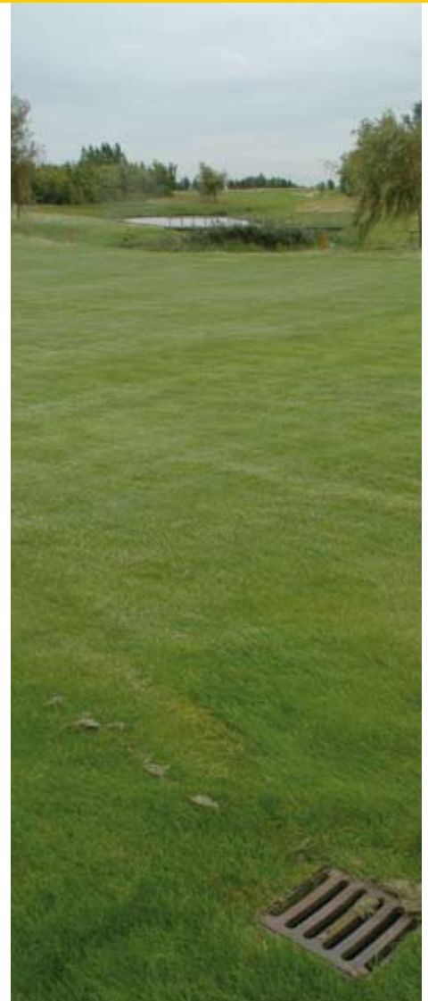
De basins volgen simpelweg de glooiingen van de baan en zo vindt het water via zwaartekracht zijn weg naar het laagste punt en door drains uiteindelijk in de sloot.
