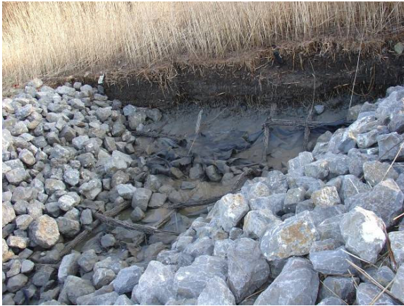
Bij opening 1 (zuid) 2004 riet aan opening, beschadiging stortsteen laag, vrij liggend geodoek.
