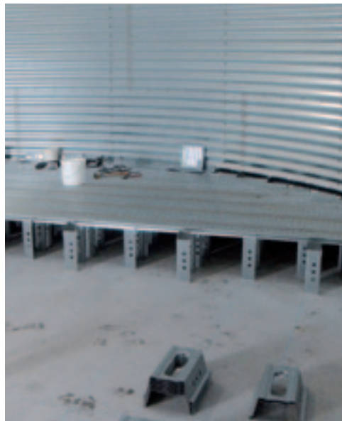
▲ Vochtgehaltes tot 19 procent zijn met de standaardbeluchting geen probleem. Is het graan vochtiger, dan zijn enkele aanpassingen nodig.
