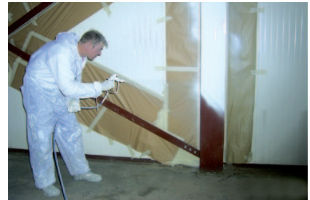
▲ De staalconstructie in een brandwand moet ook brandwerend zijn. Dat kan met brandwerende verf.
