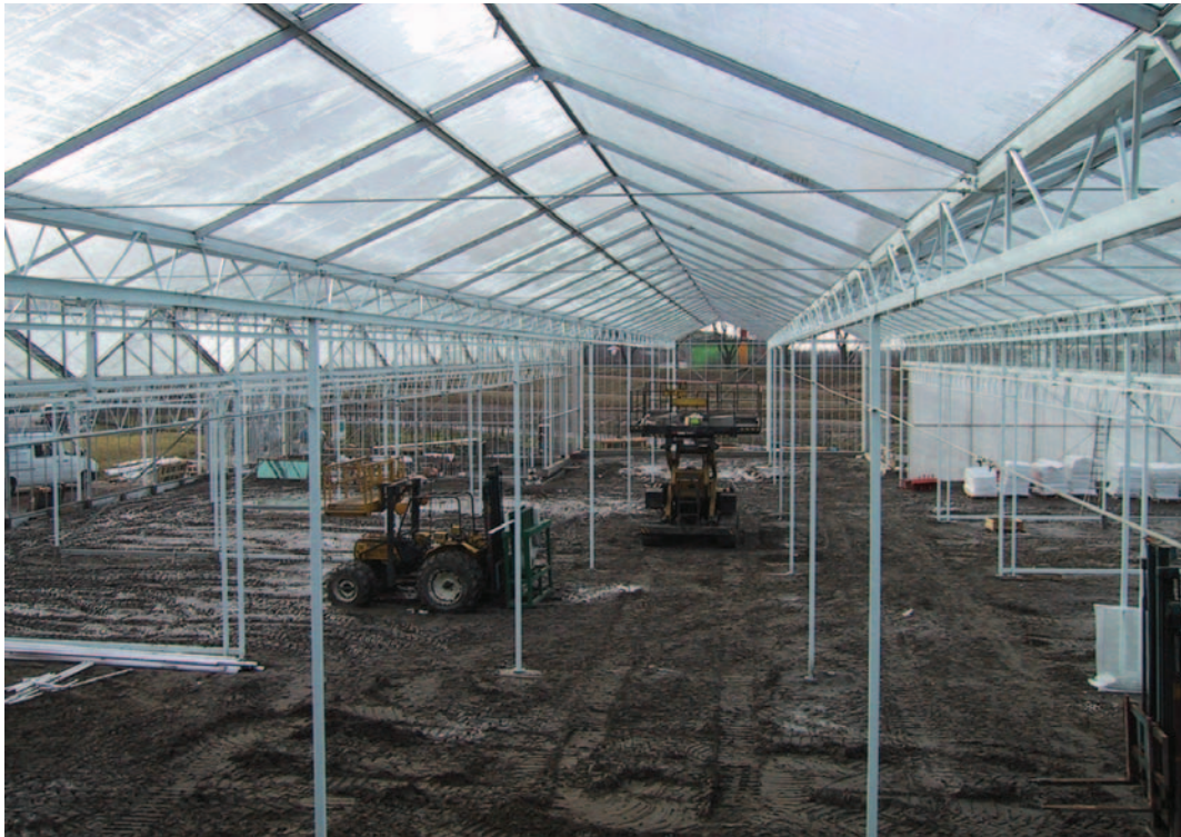
Een kas in aanbouw.
