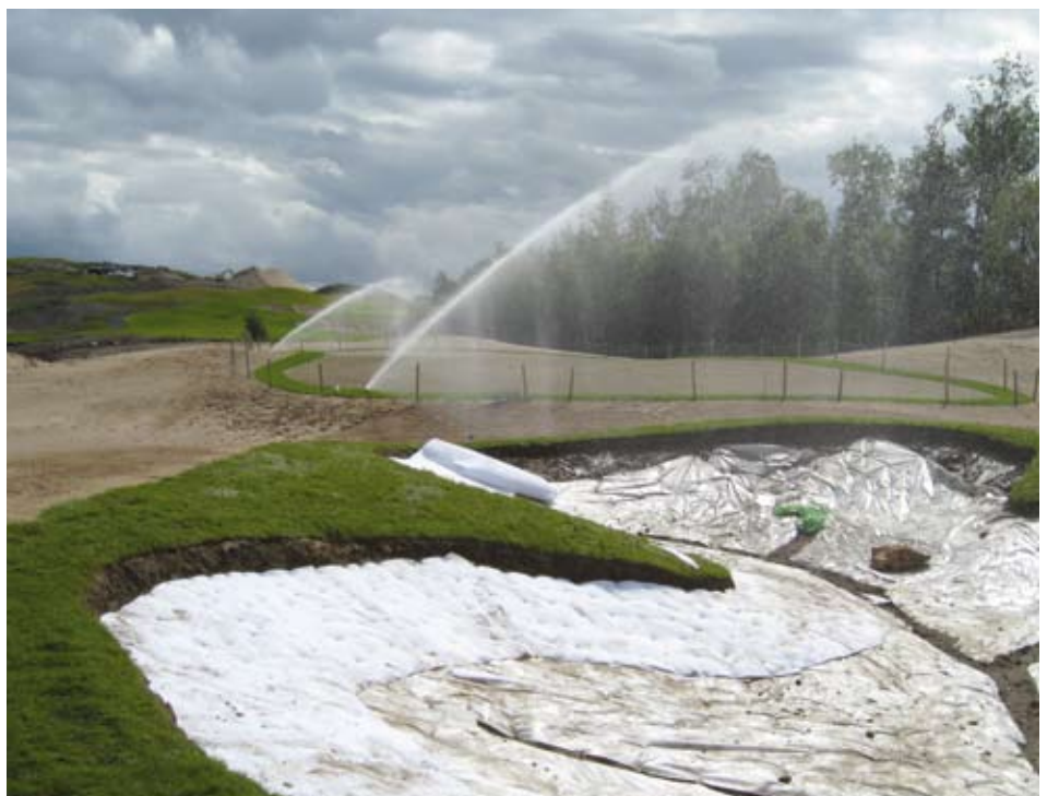
Bunker en 12e green direct na oplevering door aannemer.
