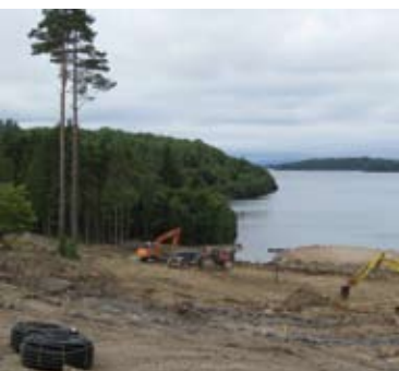
Signature' hole 10 tijdens de aanleg van drainage en beregening.
