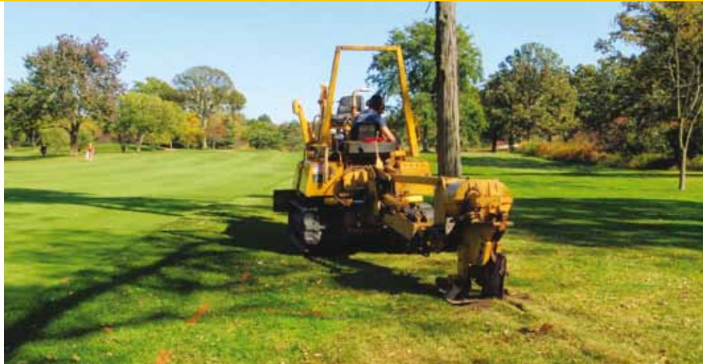
Een vibrerende ploeg kan snel boomwortels doorsnijden zonder aanzienlijke schade aan de grasmat te veroorzaken. Door met een grasrol over de ploegsleuf te gaan, verdwijnen de meeste verstoringen van het oppervlak. Zorg ervoor dat irrigatie en ondergrondse nutsvoorzieningen voorafgaand aan de snoeioperatie gelokaliseerd en gemarkeerd zijn.
