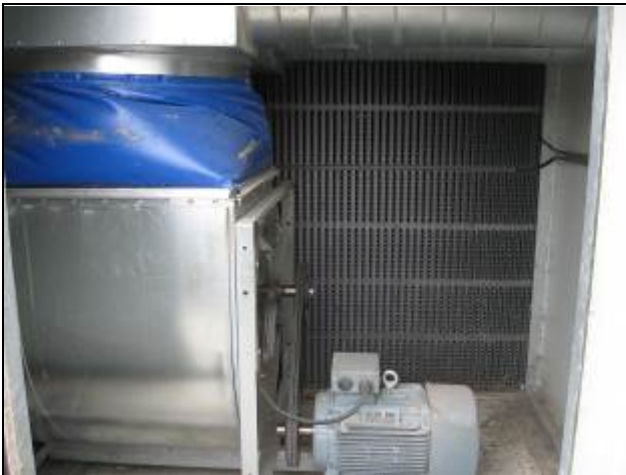
Warmtewisselaar (instroom warme stallucht)
