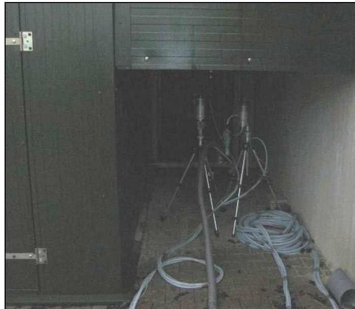
Stofapparatuur luchtuitlaat na de warmtewisselaar
