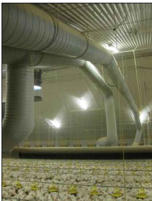
Luchtverdelingssysteem voor de verwarmde buitenlucht
