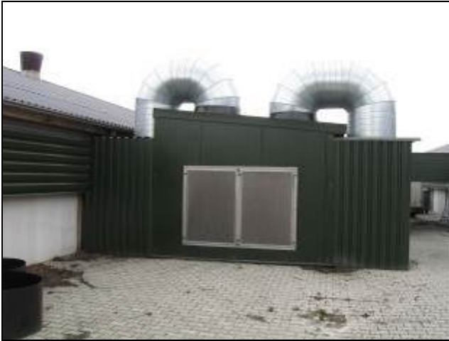
Warmtewisselaar aangepast voor de metingen. De lucht wordt i.p.v. recht omhoog, nu via de buizen in een uitstroomgang gebracht met als doel de luchtsnelheid te verlagen
