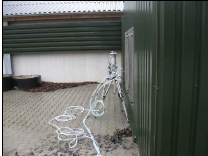
Stofapparatuur luchtinlaat vóór de warmtewisselaar
