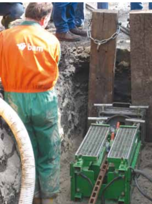
Stangen worden door de oude leiding geschoven met een hydraulische machine. Aan het einde van de stang zit een trekkop –gekoppeld aan een buis- en ruimer en daarvoor weer een breekdoorn. Alles wordt in de richting van de hydraulische machine getrokken: als een rits wordt de oude buis open- en kapotgescheurd, maar deze dient tegelijkertijd als geleiding voor de nieuwe buis.
