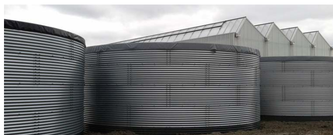
Silo's voor opslag hemelwater en testwater
