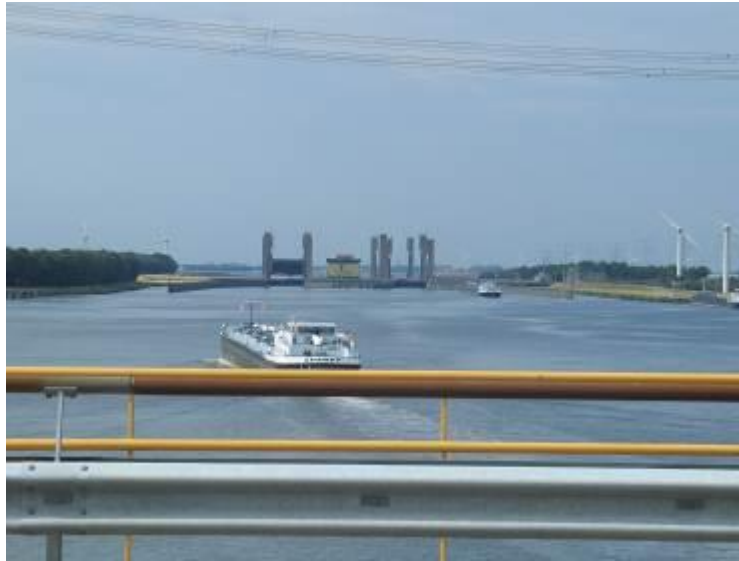
Foto: Uitzicht op de Kreekraksluizen vanaf de N289 nabij Rilland. De scheepvaart verbinding tussen Antwerpen en Rotterdam, loopt via het Volkerak.
