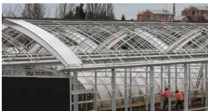
De bouw van de cabrioletkas nog in volle gang
