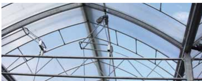
Het bijzondere aan de Roll-Air kas is dat deze een dek heeft dat in 60 seconden volledig geopend of gesloten kan worden. De folie wordt per kap met een aluminium rolbuis opgerold. De rolbuis wordt aangedreven met een Roll-Air motor met een ingebouwde koppelbegrenzer. Daardoor komt de folie elk jaargetijde feilloos op de juiste spanning te staan.
