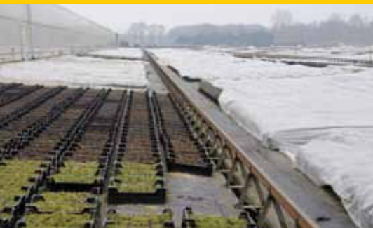
De containerbedden, die ongeveer 25 jaar geleden zijn aangelegd, zijn schuin gebouwd, zodat water snel kan weglopen. Rechts op de foto is een van de twee rails te zien waar de krattenrobot overheen rolt.
