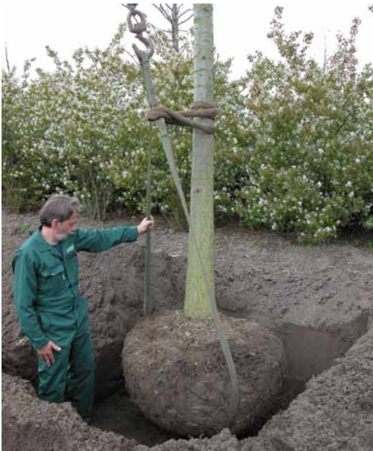
03 De boom met behulp van de strop rechtopstaand in het plantgat zetten. De strop alleen gebruiken wanneer de sapstroom in rust is.
