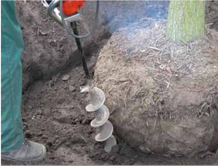
06 De gaten voor de ondergrondse verankering in de grond boren.
