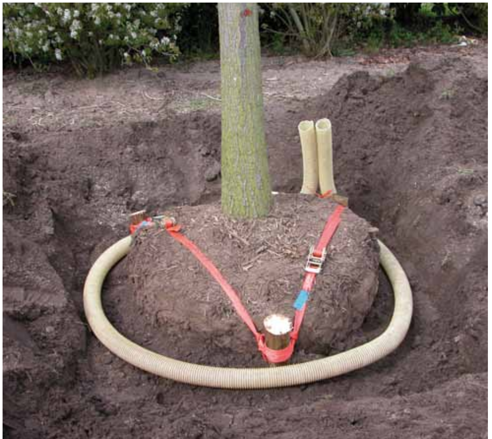
01 Breng de drainagebuis net onder het maaiveld aan.
