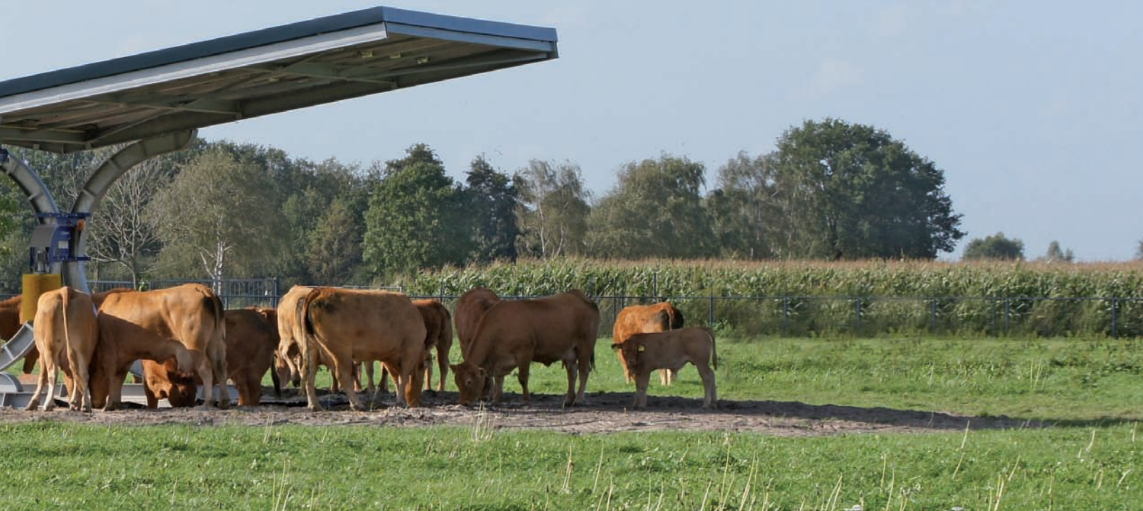
De futuristische stal Cattle Cabin met 48 zonnepanelen op het dak
