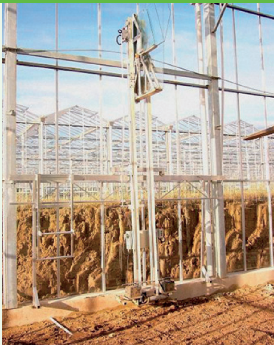
De glaslift, die tot tien ruiten kan meenemen, maakt het gevaarlijke handmatig 'opsteken' van glas overbodig.
