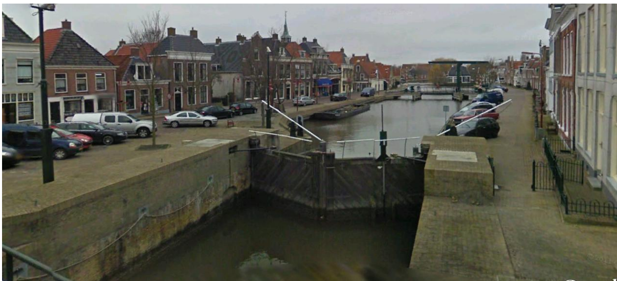
Overzicht van de sluis in Makkum (foto A&W).
