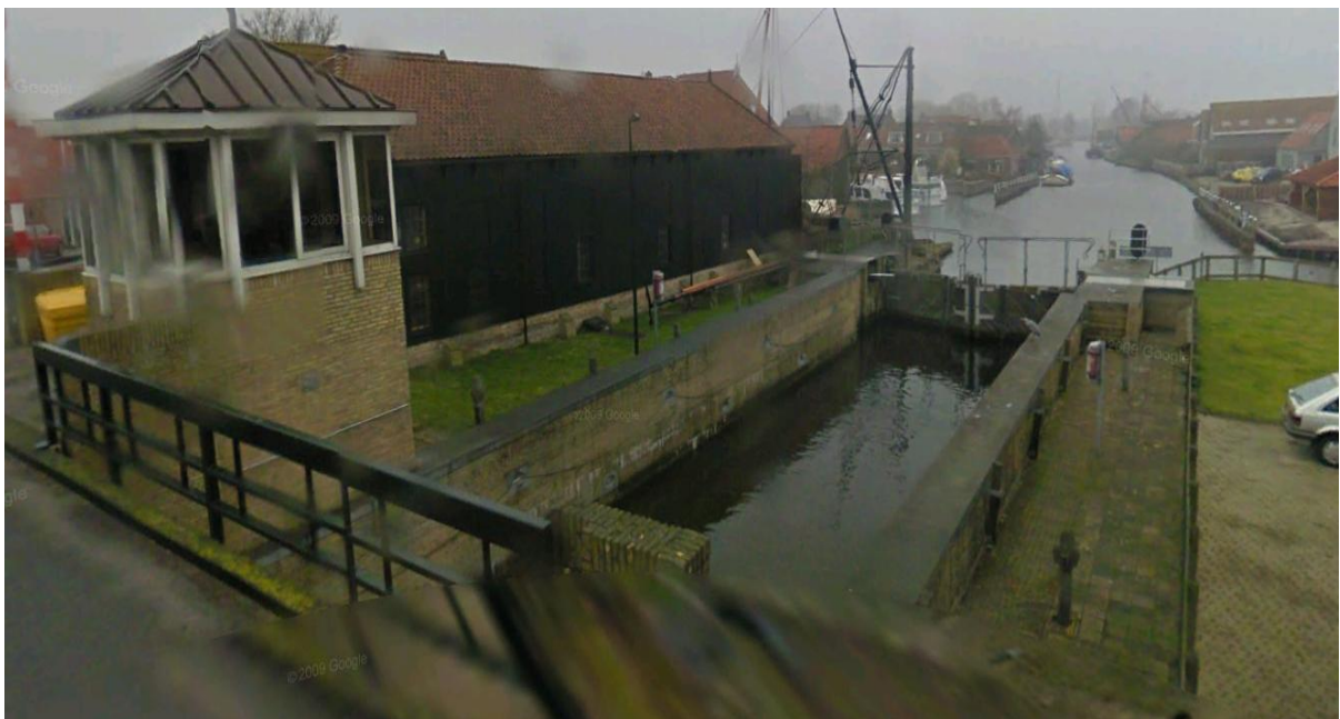
Overzicht van de sluis van Workum (foto A&W).
