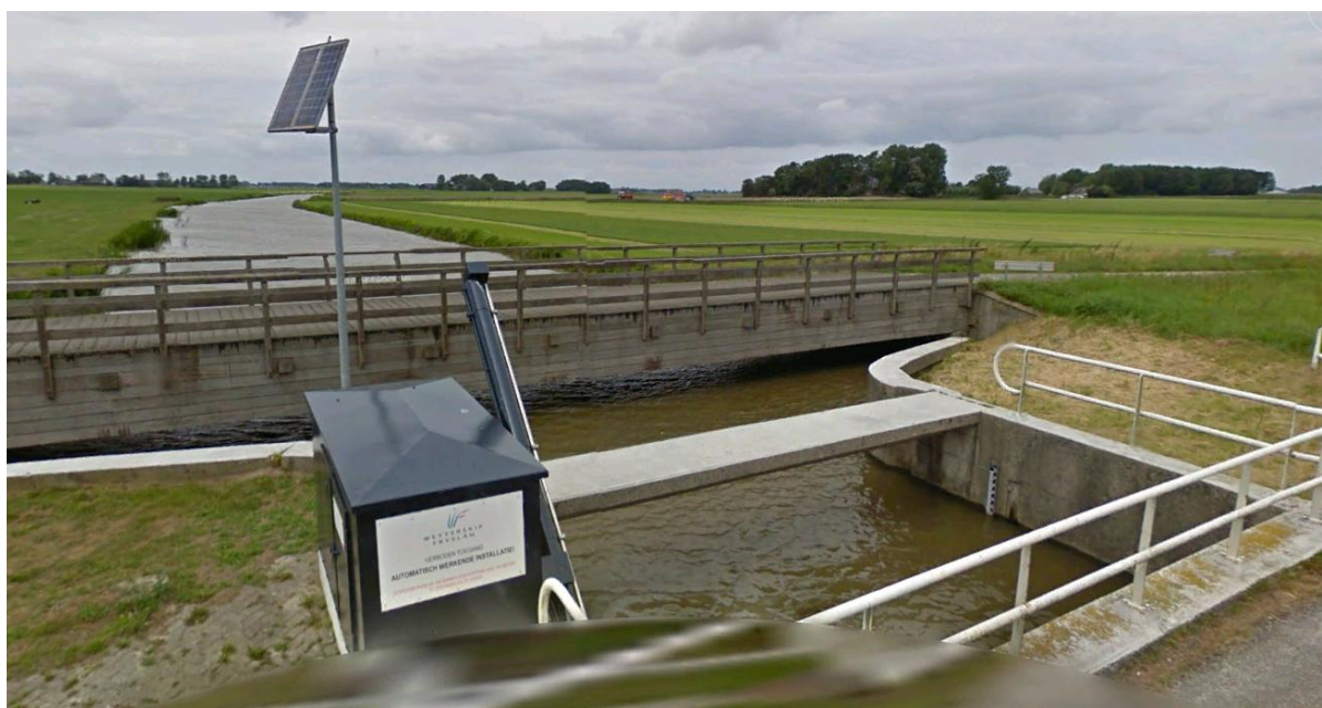
Overzicht van de stuw bij Wetzens (foto A&W).
