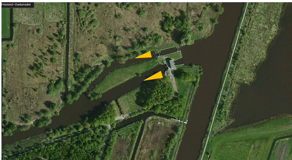
Opstelling van de fuiken bij het gemaal van de Valom tijdens de aanbodsbeplating. Onder en foto van de sluis bij de Valom.
