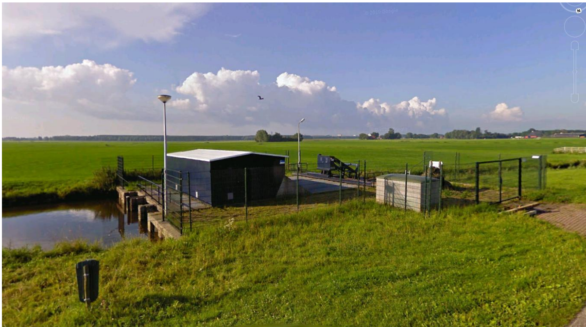
Overzicht van de onderzochte locatie (foto A&W).
