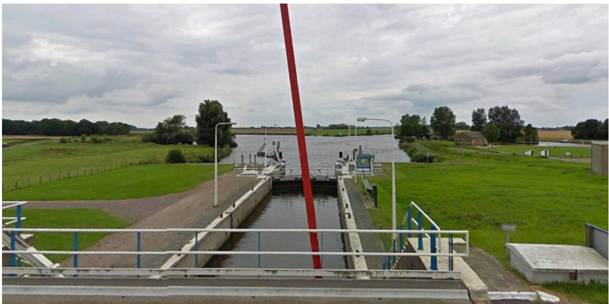
Overzicht van de onderzochte locatie (foto A&W).
