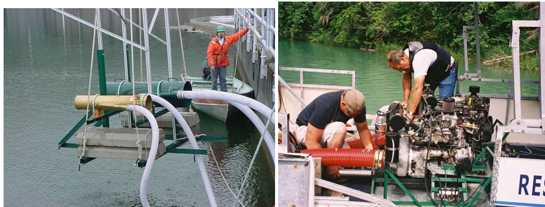
Figuur. Montage van 2 FVES eductors
