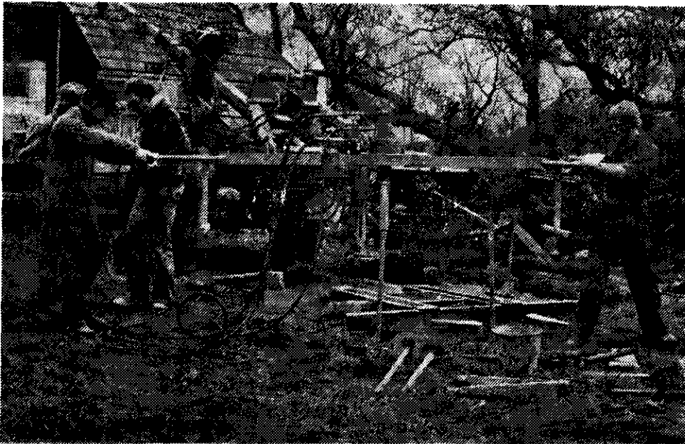
Foto 4. Het indraaien van de grondankers
