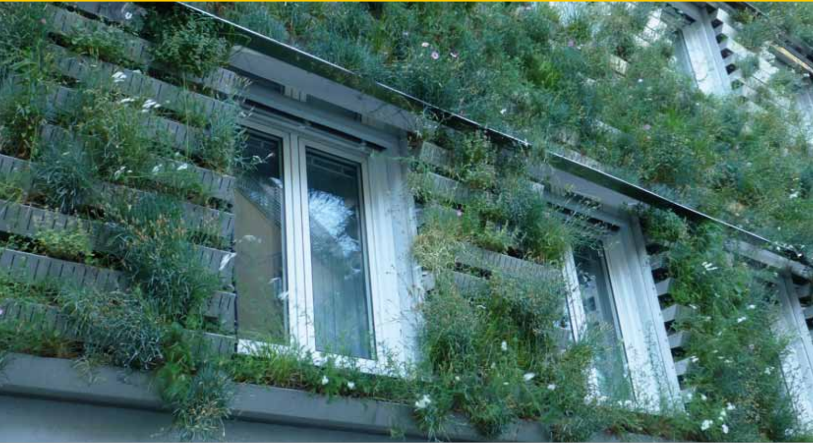
Zicht op de met inheemse kruiden beplante bakken langs de gevel van een kantoorgebouw in Wenen.
