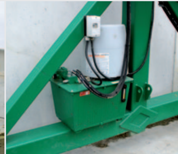
Een hydrauliekaggregaat voorziet het afdeksysteem van olie.
