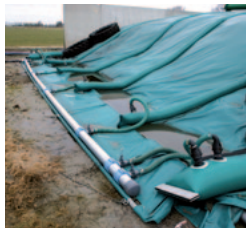
De kuil wordt afgedicht door middel van waterslurven die voorzien zijn van zout water. Die slurven liggen over de hele kuil.
