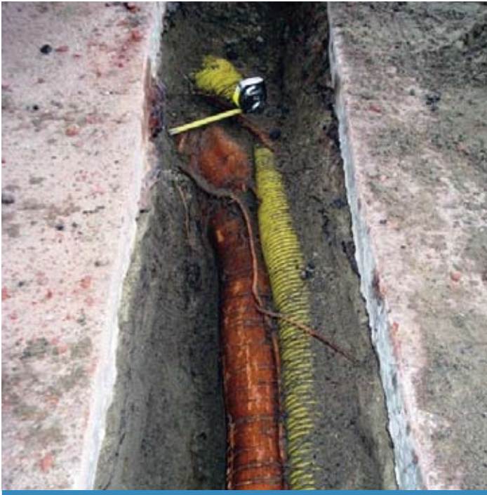
Zware wortel direct langs beluchttingsdrain
