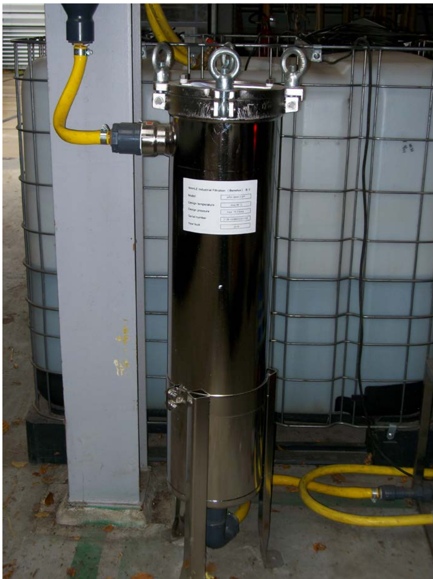
Figuur 7 Voorfilter voor zuivering van condenswater van zand- en stofdeeltjes.
