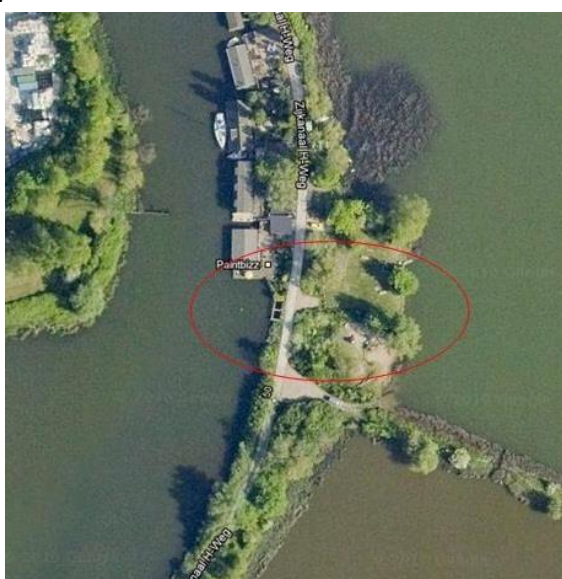
Figuur 7-1. Bedienbare stuw naar de noordplas. Links Zijkanaal H, rechtsboven de noordplas en rechtsonder de zuidplas.
