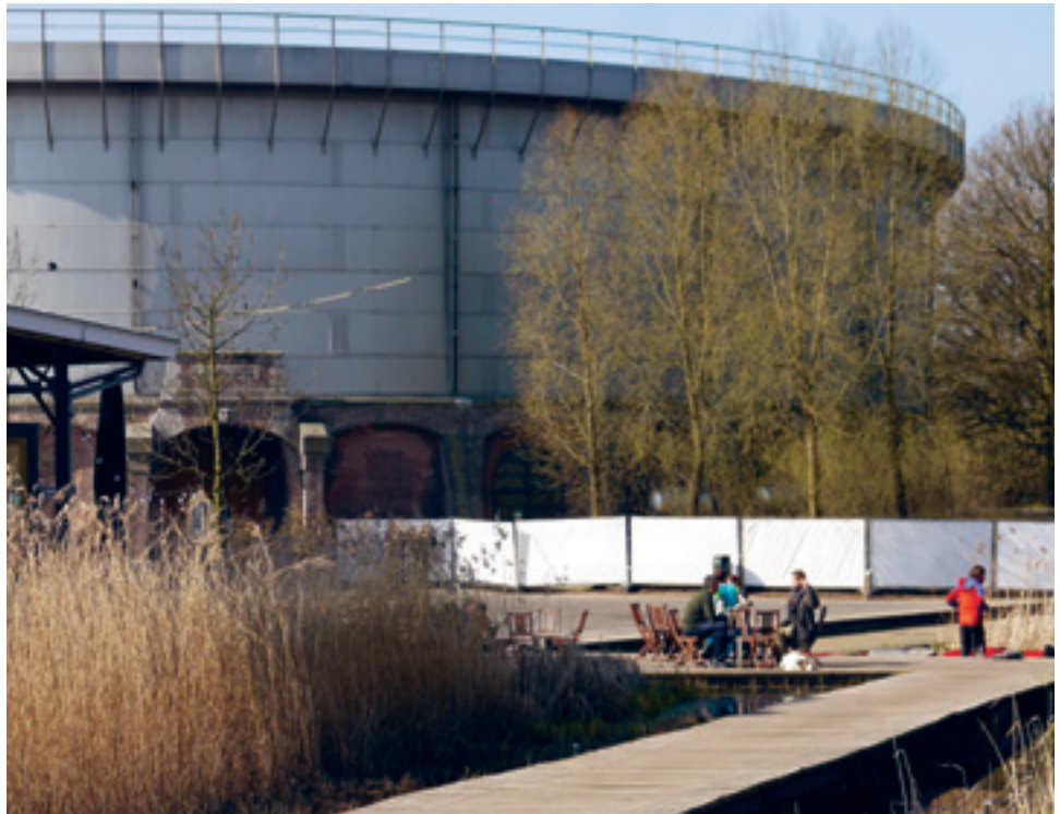
De vlonders in de ronde vijver zijn alsnog toegevoegd.
