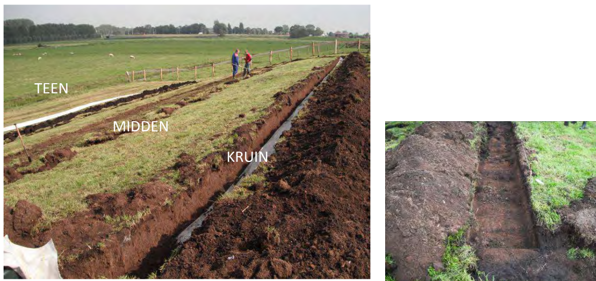
Figuur 3. Installatie van de TenCate GeoDetect® S-BR sensor in de sleuven
