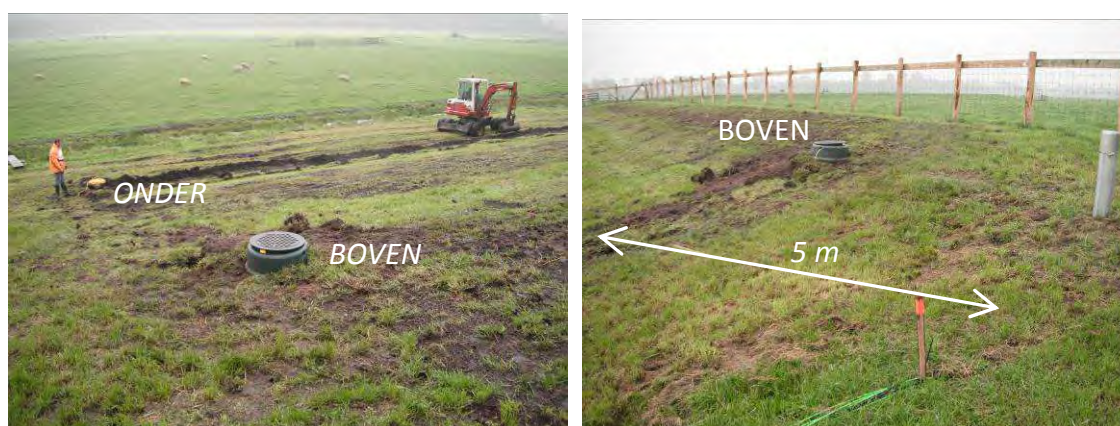
Figuur 4. De noordkant van het terrein met de twee mangaten
