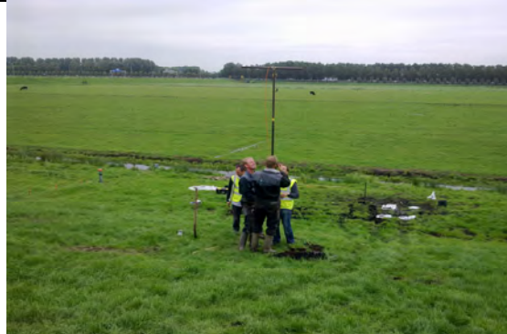
Installeren waterspanningmeter met de hand (2)
