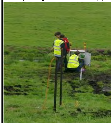
Aansluitkast Alert Solutions
