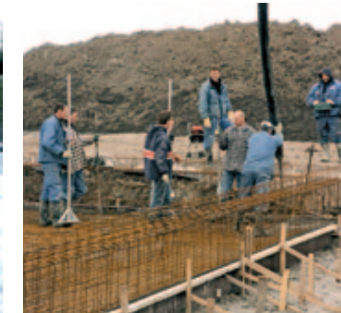
▲ Bij goede afspraken hebben alle contractpartijen hetzelfde beeld van het bedrijfsgebouw.
