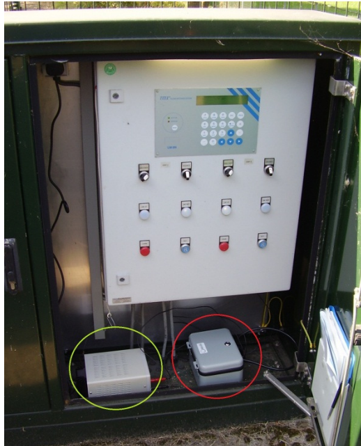
Figuur 2.2. Foto van de reader (rood omcirkeld) en de gelijkrichter (groen omcirkeld) in de stroomkast.
