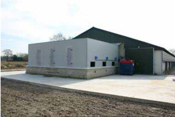
Chemische wasser achter de vleeskuikenouderdierenstal en de uitstroomopening van de uitgaande gewassen lucht
