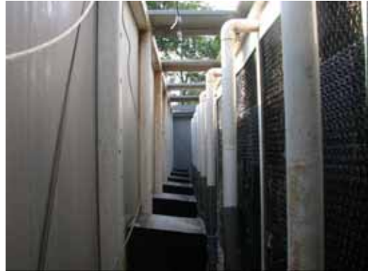
Chemische wasser achter de vleeskuikenouderdierenstal en de uitstroomopening van de uitgaande gewassen lucht
