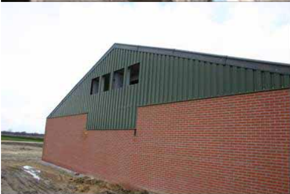
Situatie van de ingaande lucht van een chemische wasser bij het module concept en de openingen voor uitgaande lucht bij een zijwaartse uitstroming.
