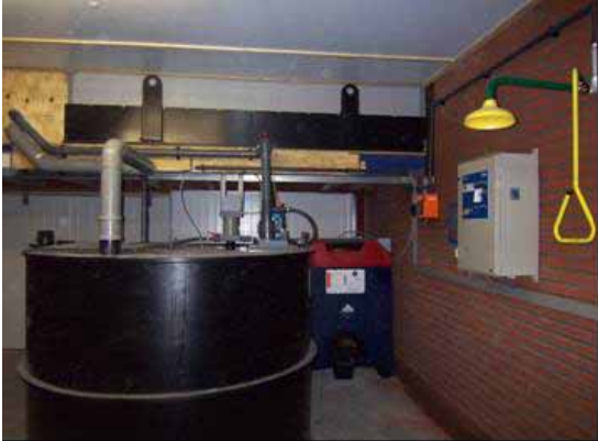
Centrale mengtank en chemische wasser met daarvoor de drukkamer (hout)
