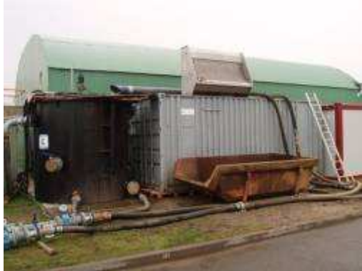
Figuur 3.3: zeefbocht bovenop de container met daarnaast de mengbuffer.
