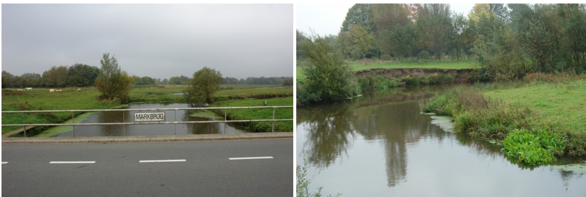
Figuur 18 Links vanaf de 'Markbrug' is de insteek van de eerste bypass te zien. Rechts een detail opname van de eerste bypass. Goed is het contrast tussen de steile oever in de buitenbocht te zien met de flauwere oever in de binnenbocht.
