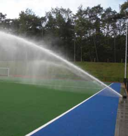
De nieuwe installaties in Zwolle en Houten voorzien het veld van 2mm water binnen 12 minuten
