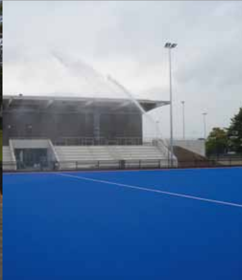
De nieuwe installaties in Zwolle en Houten voorzien het veld van 2mm water binnen 12 minuten
