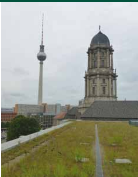
Het groendak op het kantoor van het Berlijnse Waterbedrijf.
