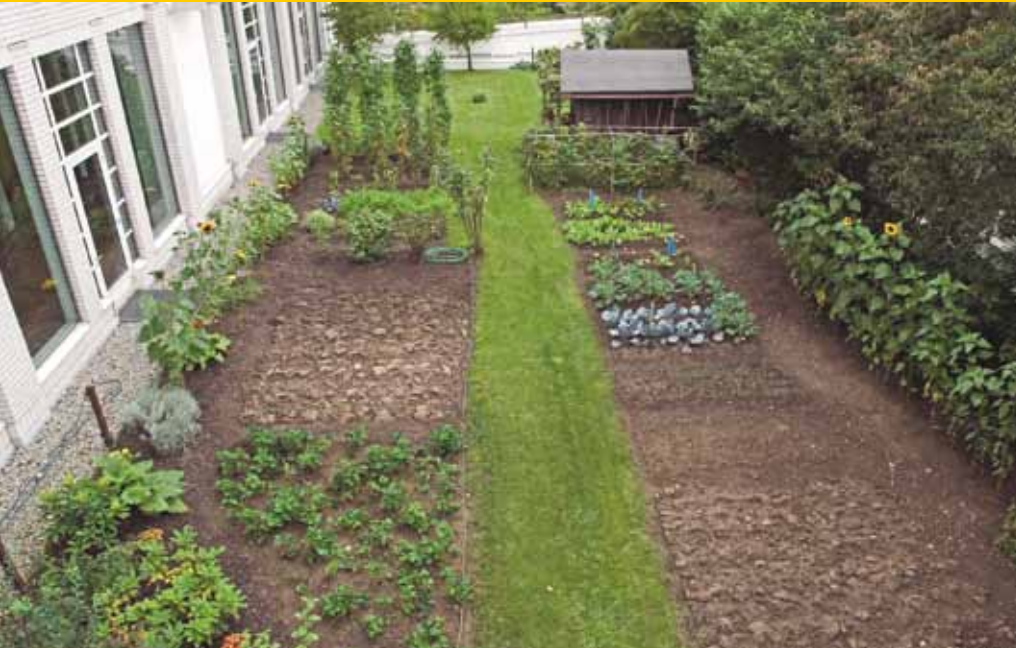
Een dak dat zich vrijwel als onverhard oppervlak gedraagt.
