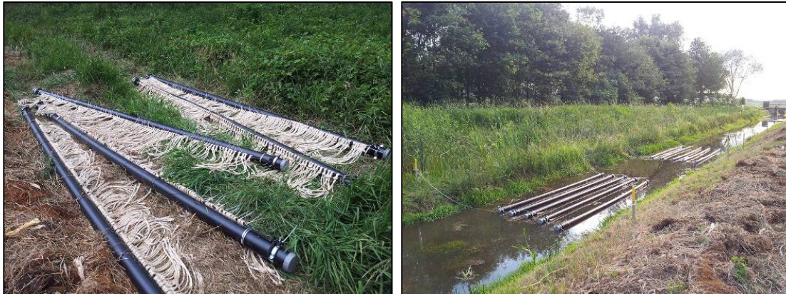
Figuren 2.6a & b: Plaatsing perifytonfilter
