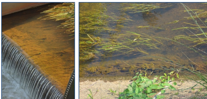
Figuur 3.3a & b: Aangroei van perifyton bij harde constructie rondom stuw in juli 2012
