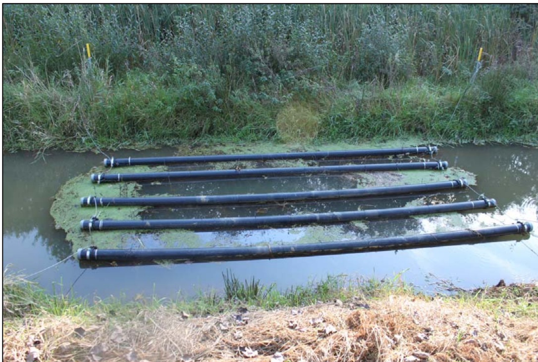
Figuur 2: Gerealiseerde drijfconstructie in Overasselt. De touwen hangen in het water en zijn niet zichtbaar
