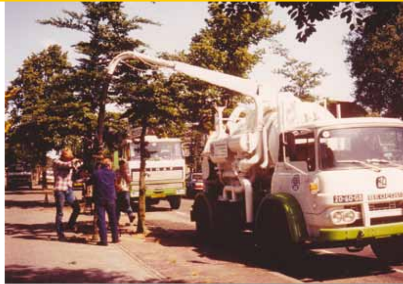
Aanbrengen van voedingspijlers in Soest, 1978.
