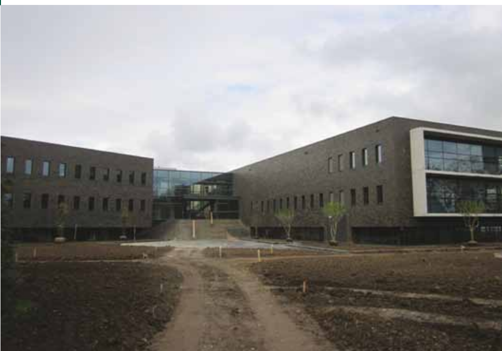
Aanlegfase van het Berkelpad.
